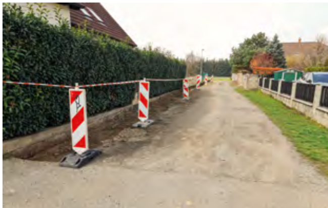
Příprava pro nové obrubníky v ulici Pšeničná
