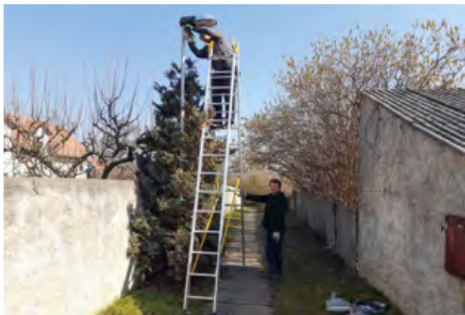
Pan Jiří a Karel z TS při instalaci nového svítidla
