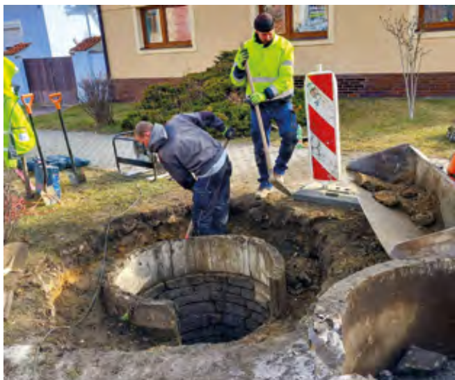
Pan Jan a Radek z TS při rekonstrukci studny
