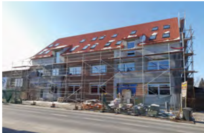
Druhá budova s novými okny a obložením fasády
