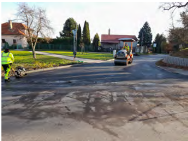
Dokončovací práce napojení na hlavní silnici
