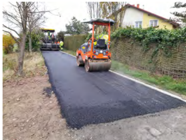
Asfaltování poslední části nové cyklostezky
