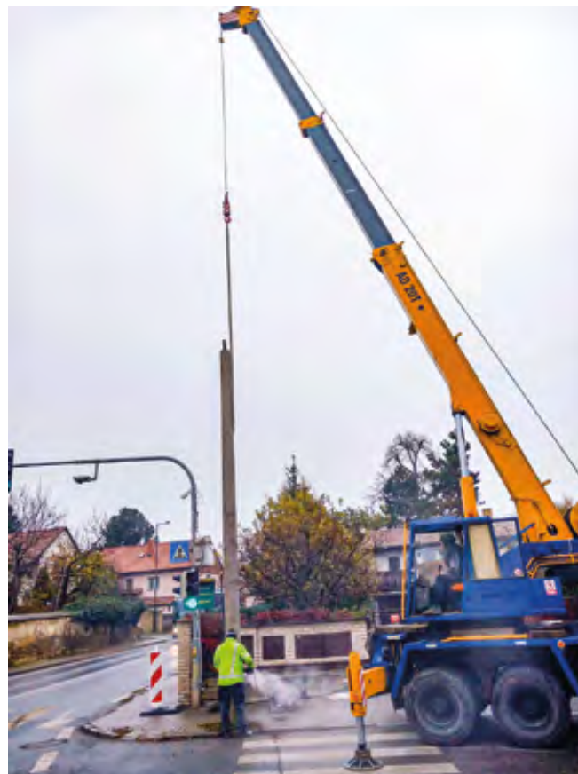
Pan Jiří z TS při odřezávání starého betonového sloupu VO
