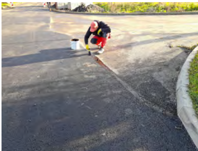
Ošetření spár napojení původní a nové části silnice
