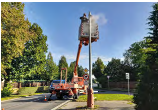
Pan Jiří a Karel z TS při odřezávání starého stožáru VO
