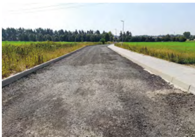
Silnice již jen čeká na finální pokládku asfaltu
