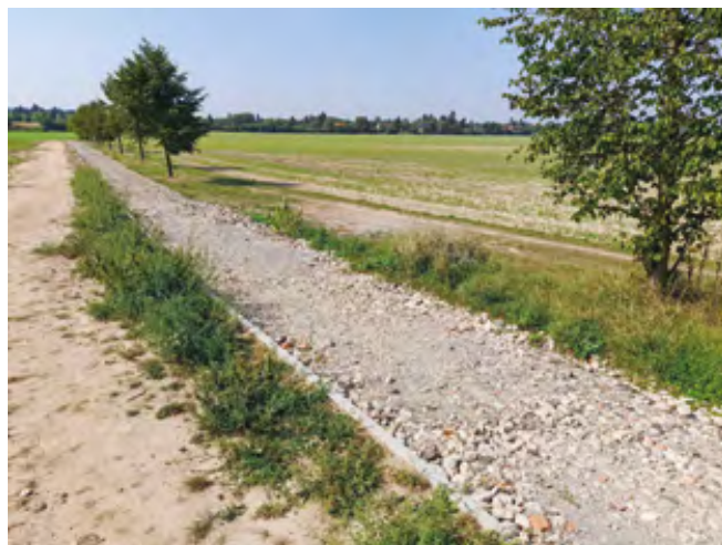
Dokončené obruby a první základová vrstva nové cyklostezky
