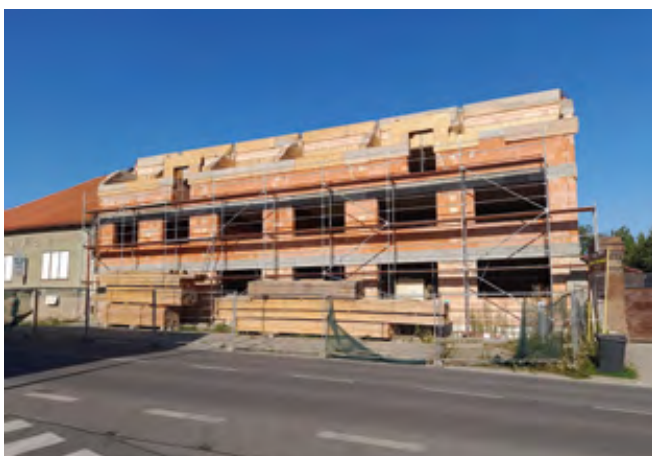
Hrubá stavba první budovy
