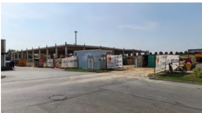
Skelet nového obchodního objektu
