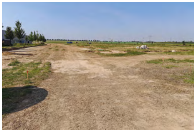
Zemní práce pro nové komunikace
