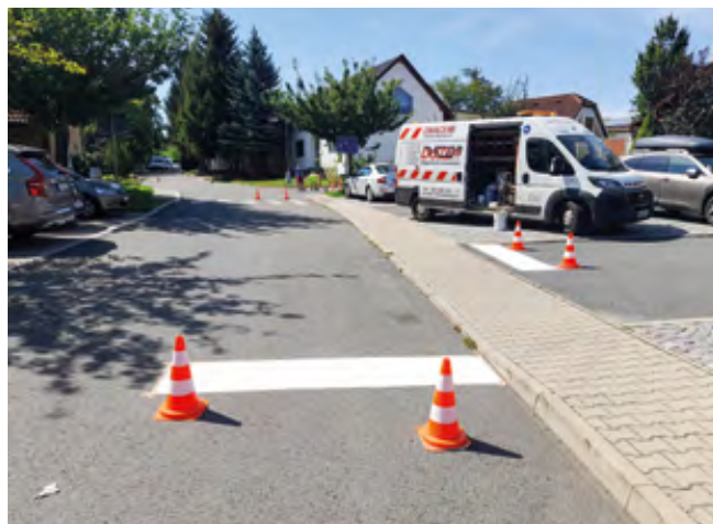
Instalace nového dopravní značení V5
