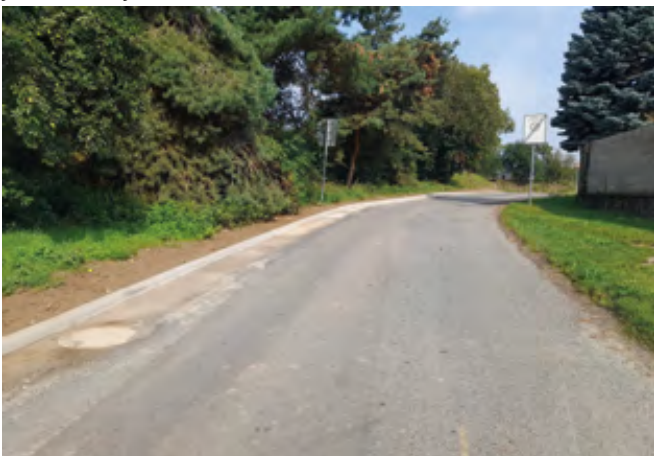
Nové obrubníky v ulici Lipová
