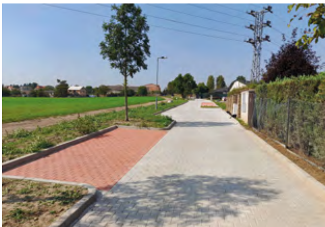
Převážná část ulice již byla dokončena
