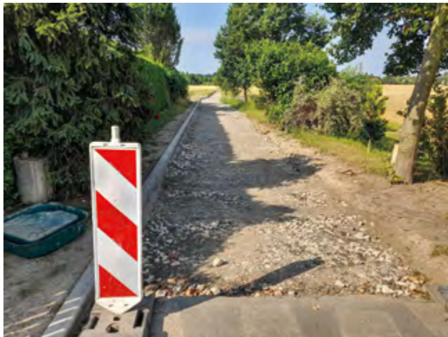
Část cyklostezky je již připravena pro nový povrch
