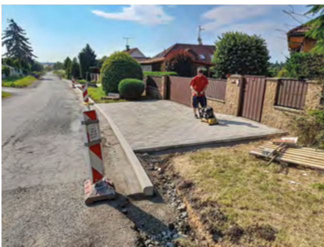
Pan Karel z TS při budování nového vjezdu v ulici Lipová
