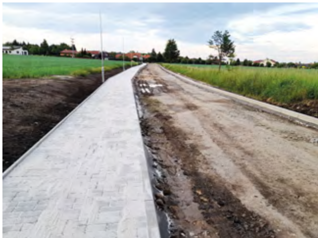
Stavba nové komunikace v ulici Potočňní
