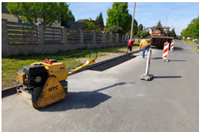
Oprava silnice v ulici Běchovická
