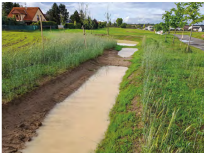
První zachycená voda v zadržovacím příkopu
