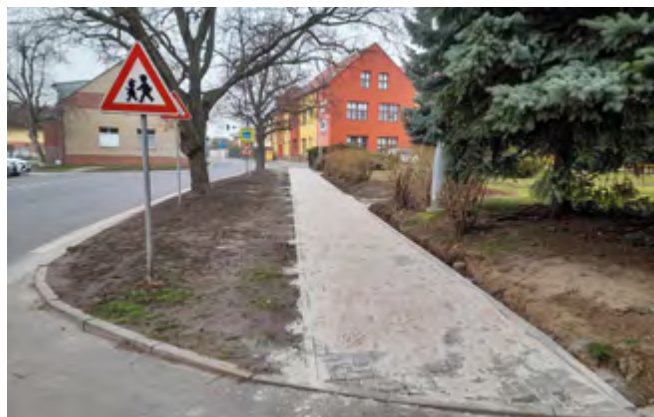
Nově zrekonstruovaný chodník v ulici Komenského
