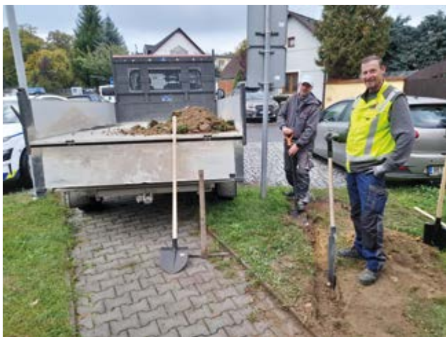
Pan Luděk a Radek z TS při budování výkopu
