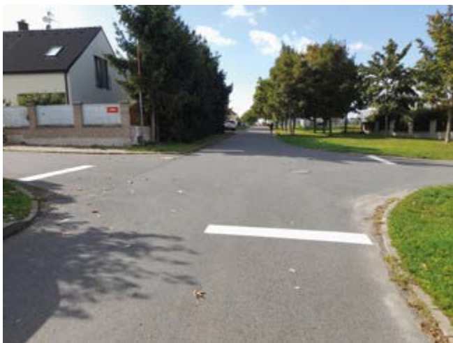
Nové dopravní značení v ulici K Remízkům
