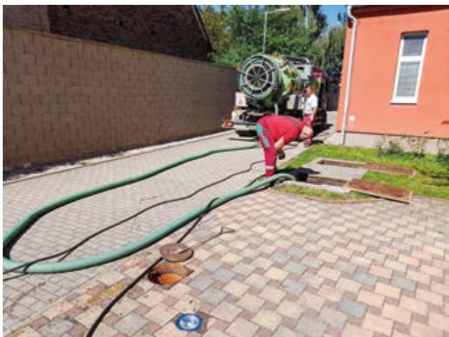
Čištění kanalizační přípojky u budovy ZŠ
