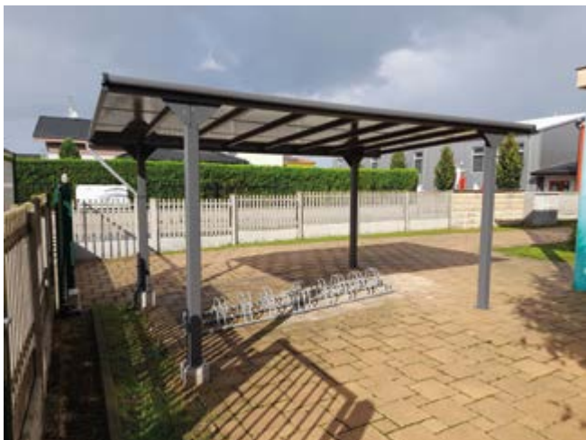
Nový přístřešek nad stojany v MŠ
