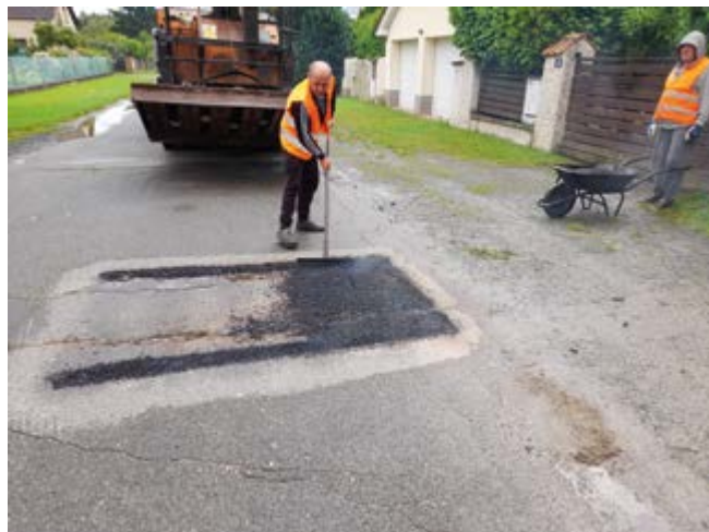
Narušení původního povrchu a dodání nového asfaltu
