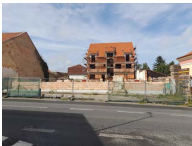
Hrubá stavba a základy nových budov
