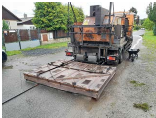
Tavení asfaltového povrchu plynovým zářičem
