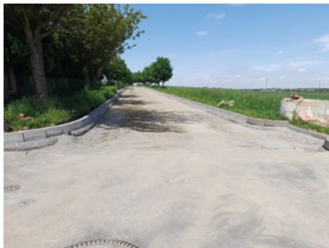
Stavba nové propojky v ulici V Cestách
