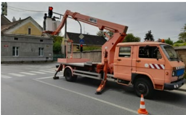
TS při opravě semaforu v ulici Revoluční
