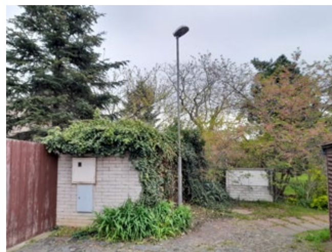
Zkorodovaný stožár nahradil stožár nový
