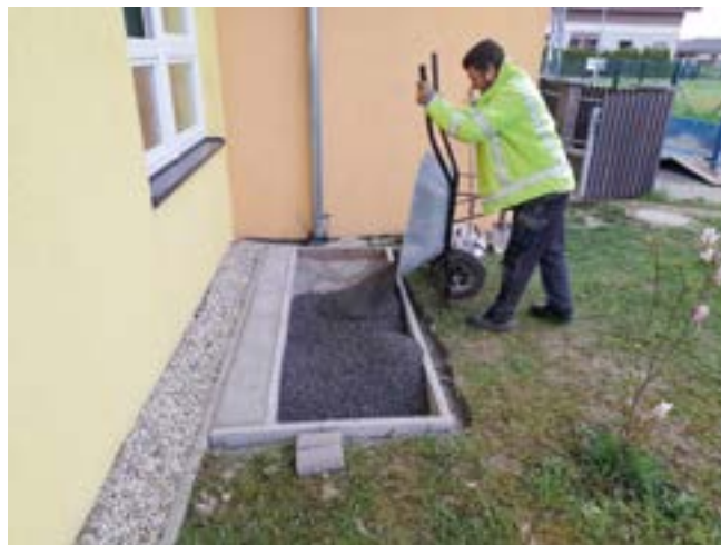
Budování plochy pro nový stojan na koloběžky...
