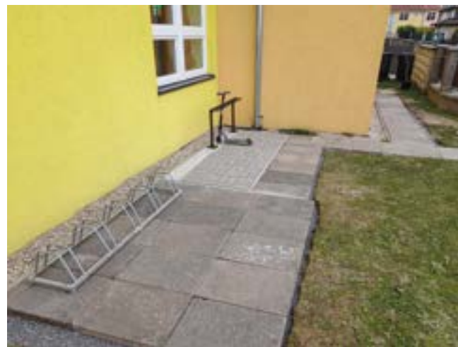
...a již instalovaný stojan s nových chodníkem
