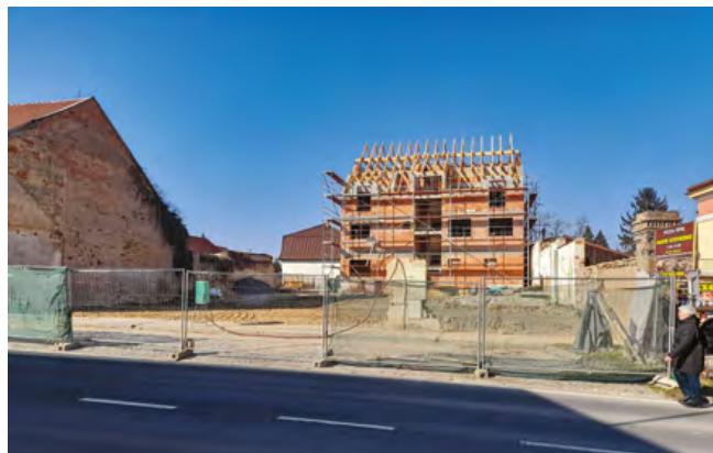
Přední budova již byla zcela demolována
