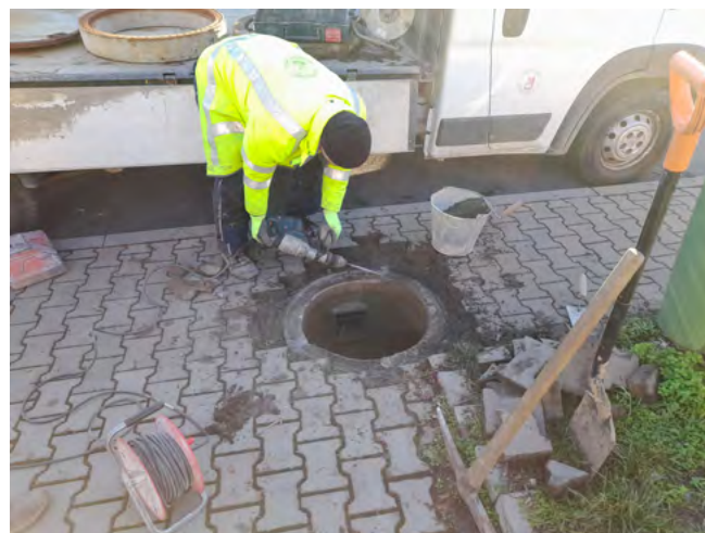
Pan Jiří z TS při bourání původní vpusti
