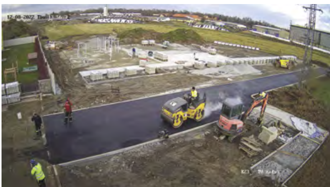
Budování příjezdu k novým parkovacím místům
