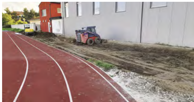
Příprava pro vybudování základů pro tribunu
