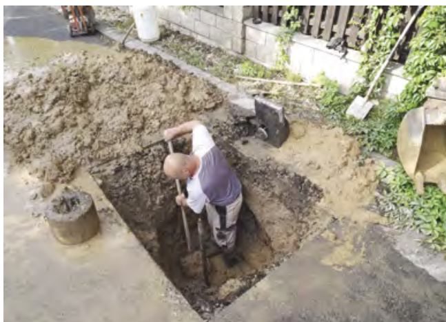
Odstranění nasáklé zeminy bylo namáhavé
