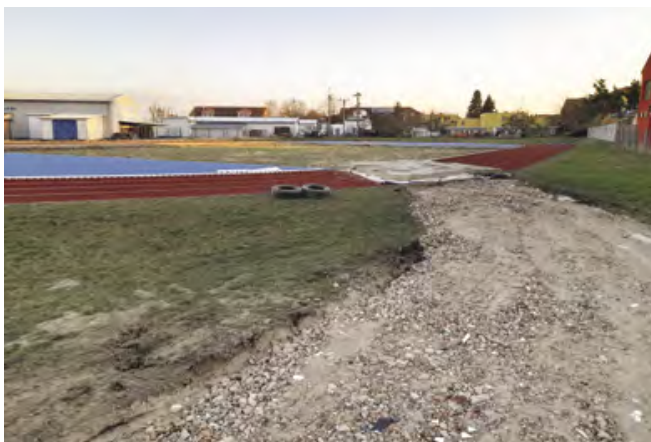
Příprava na zahájení výstavby umělé herní plochy
