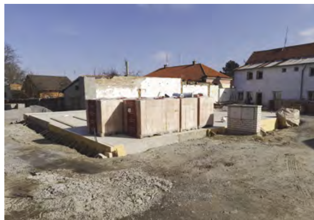
Byla zahájena hrubá stavba nové budovy
