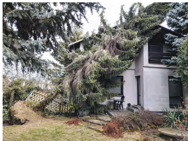
Strom po vývratu spadl na rodinný dům
