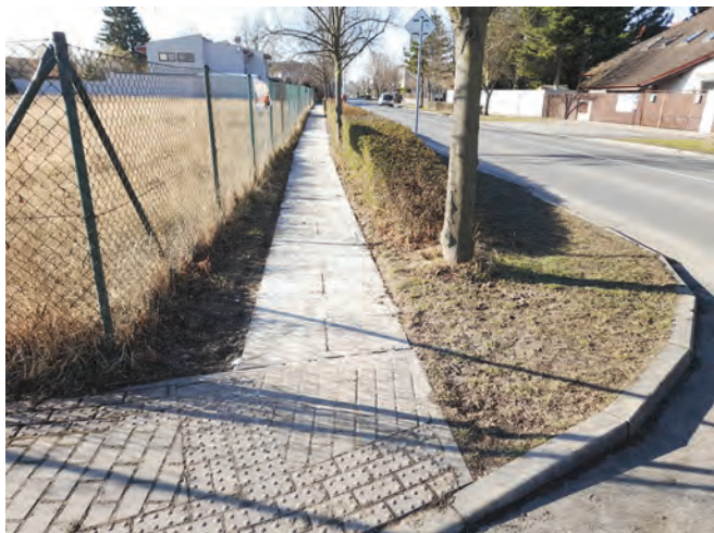
Chodník: Nově vybudovaná část chodníku
