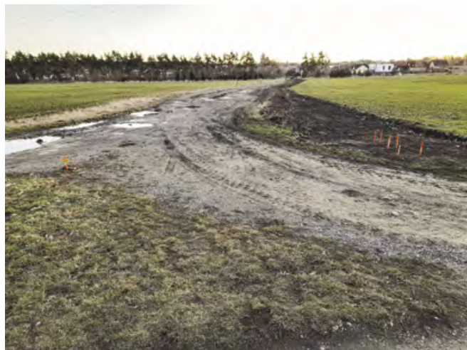
Zahájení prací v ulici Potoční
