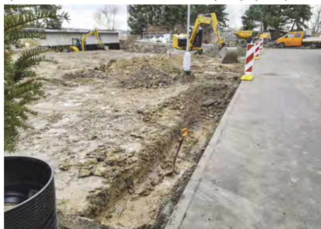
Přípravné zemní práce pro základy nové technologie
