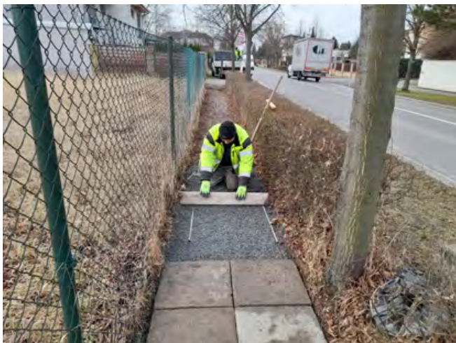
Budování chodníku u hlavní silnice
