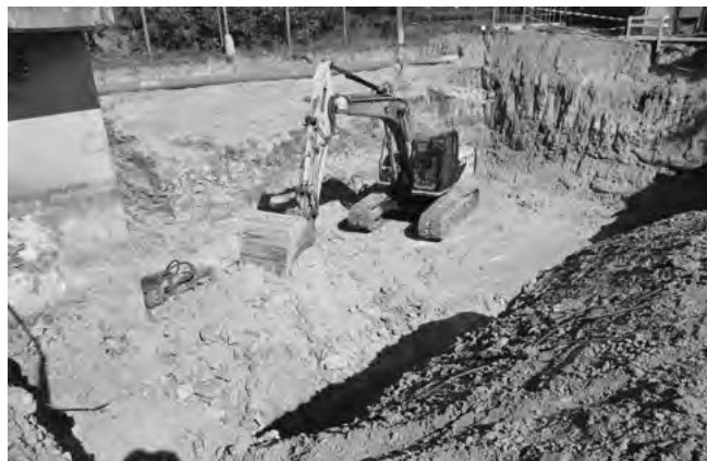
Budování základů nové části ČOV
