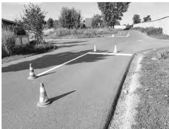
Práce na umístění DZ v ulici Manželů Starých
