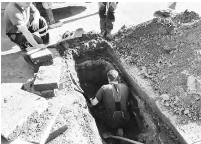
Zaměstnanci TS při opravě havárie vodovodu
