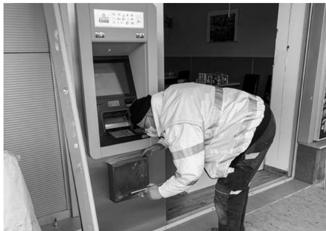
Instalace nového bankomatu
