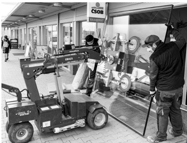
Montáž nové výlohy
