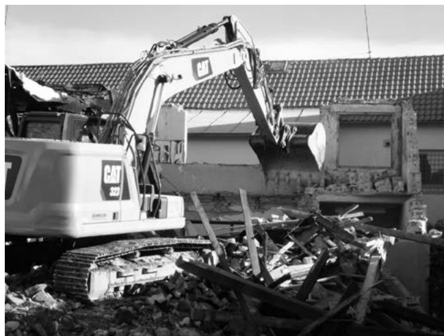
Demolice zadní budovy
