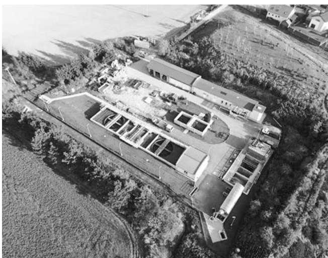
Pohled na ČOV po první rekonstrukci v roce 2011 Foto: Jiří Matějka
